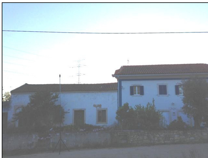
Foto 8 - Ponto de Medição Acústica RA localizado em Arazede (Linhaceiros), junto de habitação com dois pisos e a cerca de 86m a Norte do eixo da Linha da REN em análise (Vão entre o Poste 91 e o Poste 92 da Linha); (Coordenadas Google Earth: 40.261711°; -8.641452°).
