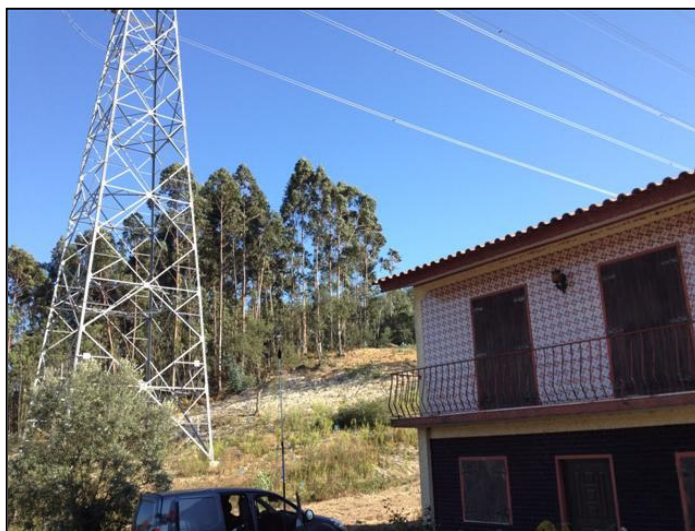
Foto 6 - Ponto de Medição Acústica R6 localizado em Bolho (Casal do Bolho), junto de habitação com dois pisos e a cerca de 29m a Norte do eixo da Linha da REN em análise (Vão entre o Poste 148 e o Poste 149 da Linha); (Coordenadas Google Earth: 40.407105° ; -8.510043°).
