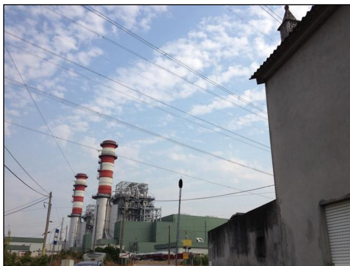
Foto 1 – Ponto de Medição Acústica R1 localizado em Vila Verde(Lares), junto de habitação com dois pisos e a cerca de 59m a Poente do eixo da Linha da REN em análise (Vão entre o Poste 28 e o Poste 29 da Linha); (Coordenadas Google Earth: 40.126184° ;-8.776618°).
